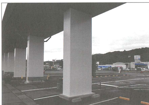
高架橋柱鋼板巻付け耐震工事
