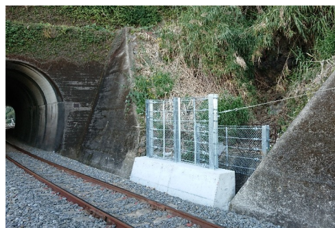
土砂流入箇所へのストーンガード設置
